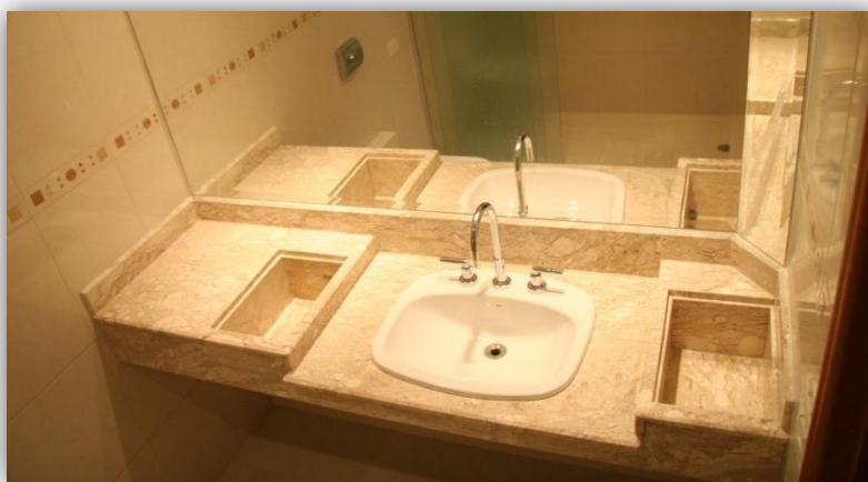
Figura 34: Torneira acionada por alavanca com sistema de \frac{1}{4} de volta. Fonte: Renata Lima de Mello – Acervo pessoal – São Paulo, 2008.
