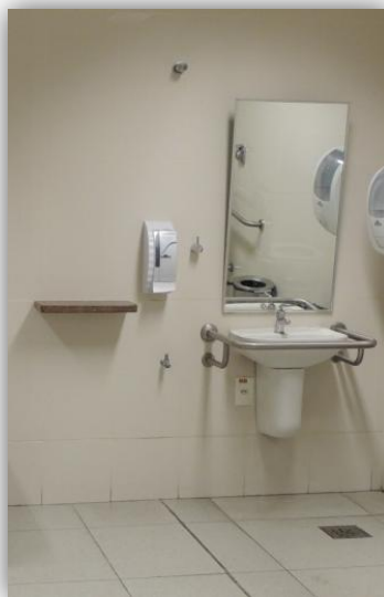
Figura 26: Lavatório com barra de apoio e proteção no sifão. Fonte: Renata Lima de Mello – Acervo pessoal – São Paulo, 2013.
