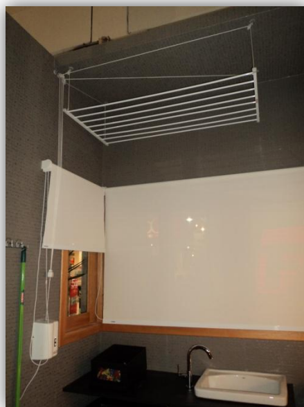
Figura 33: Varal de teto com central elétrica para acionamento. Fonte: Renata Lima de Mello – Acervo pessoal – São Paulo, 2012.
